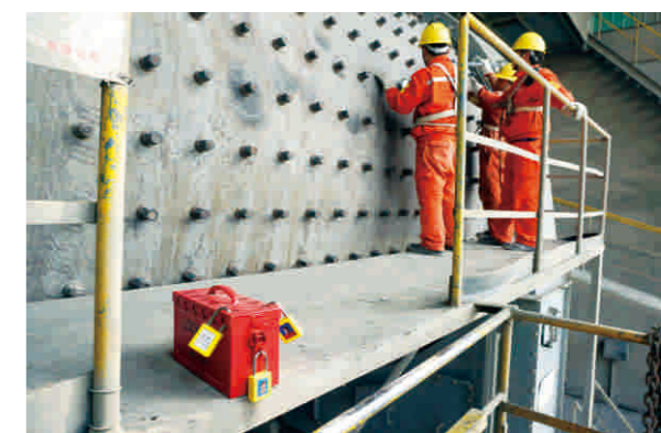
武穴公司磨检修时进行隔离加锁 Wuxue Co. carry out isolation & lockout before maintenance
