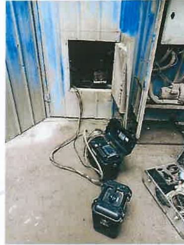
C2 线水泥磨排气筒
