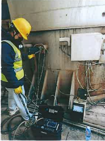
K2 线窑尾废气处理设施排气筒
